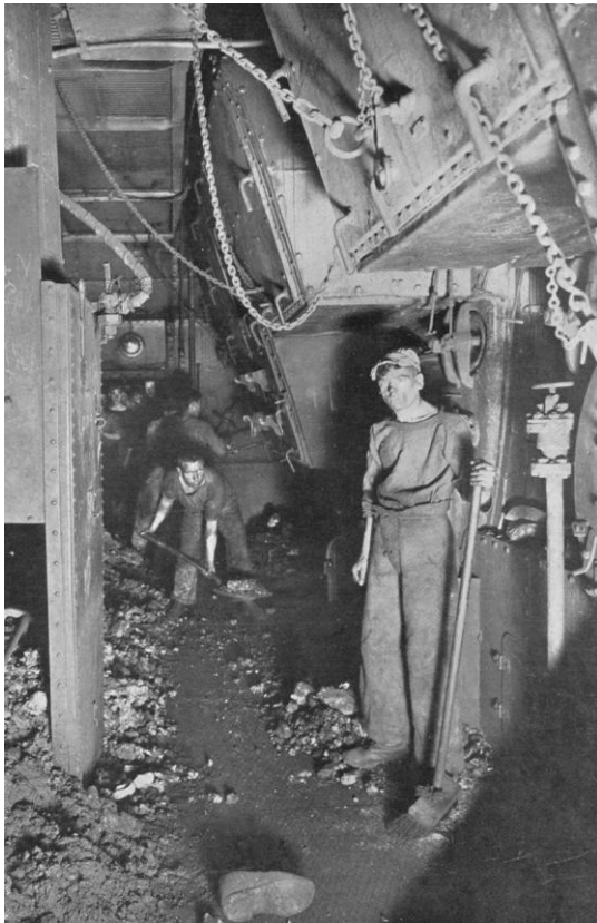
Chaufferie d'un cuirassé (1914)
